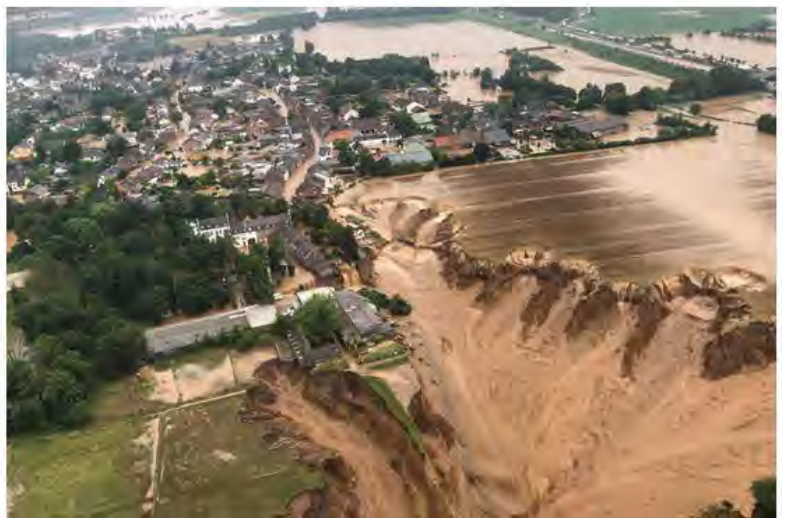
Das Gelände der Grube soll nun teilweise in ein Auengebiet umgewandelt werden, das Blessem künftig vor Überströmungen durch die Erft schützen soll. © Rhein-Erft-Kreis/dpa
